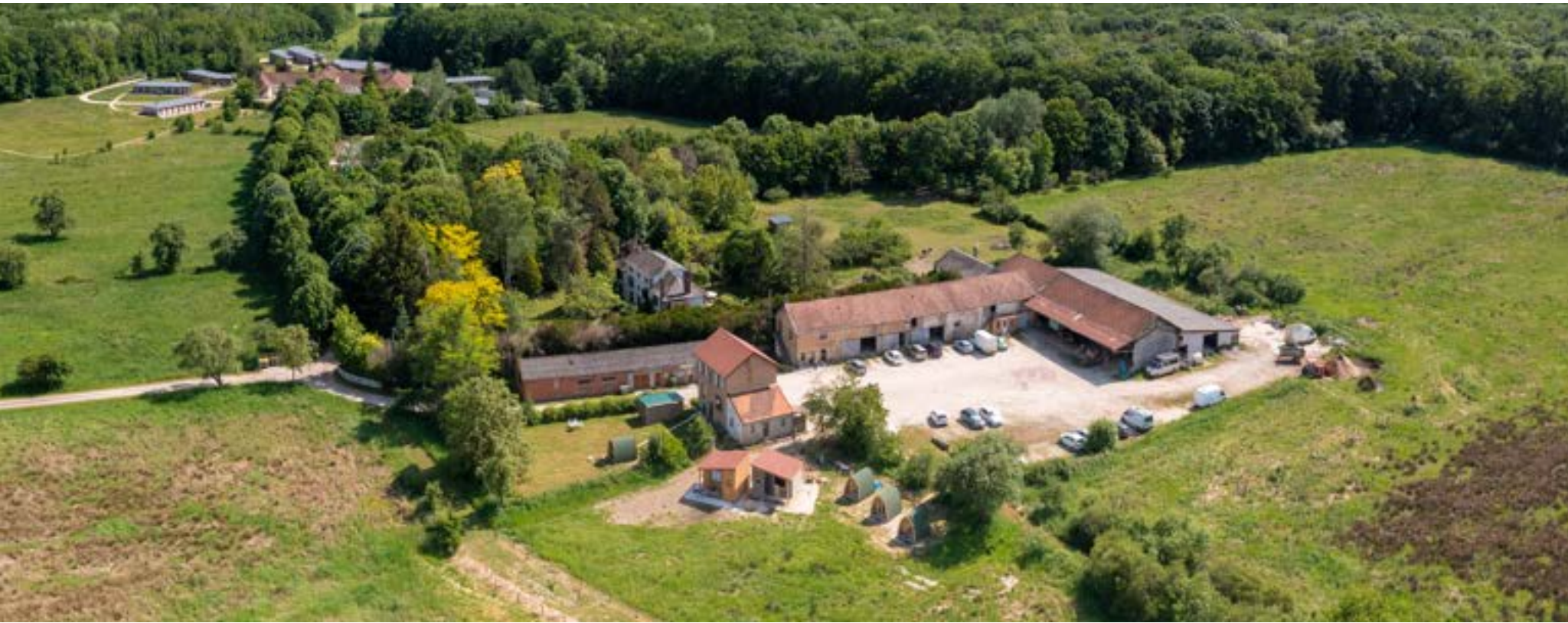
Vue de la Ferme, depuis le nord-est
