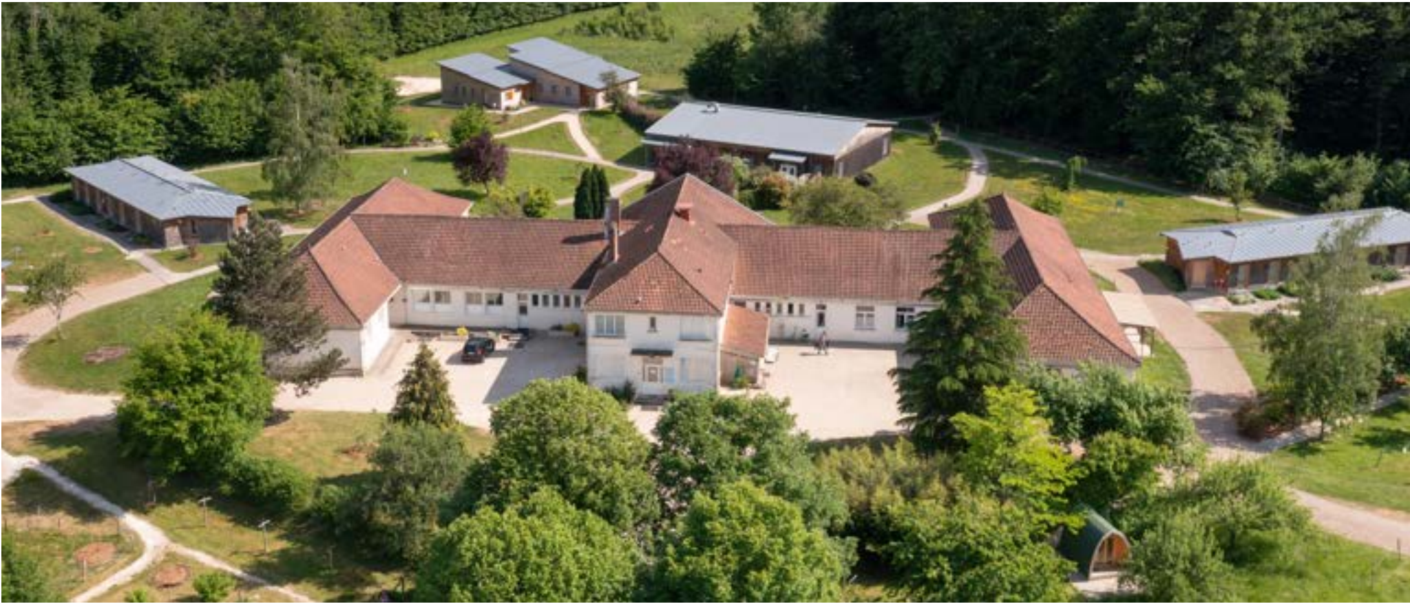
Vue depuis le nord
