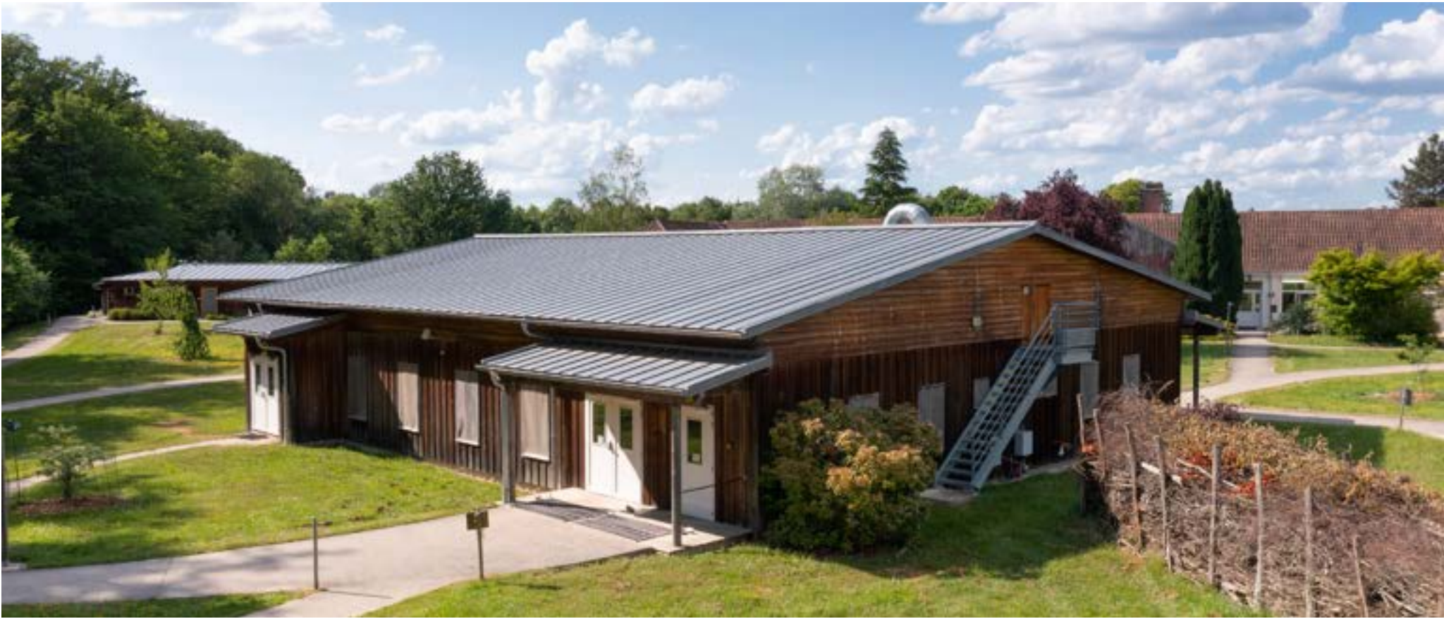
Vue depuis le sud
