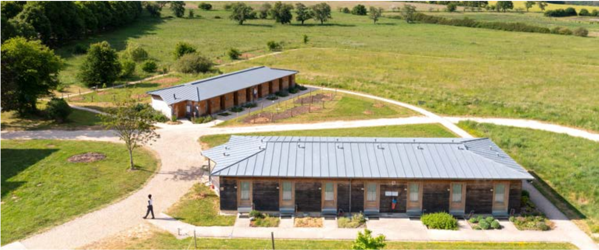
Vue depuis le sud-est
