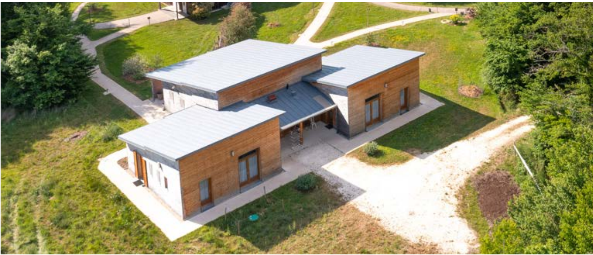
Vue depuis le sud-est
